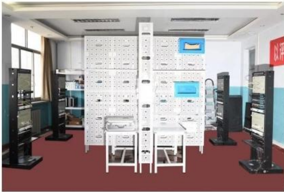
网络综合布线实训室
